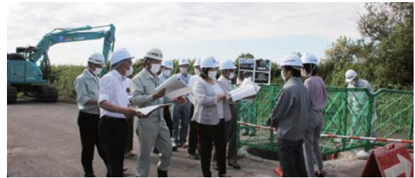
下水道管更新工事現場（太美北）
